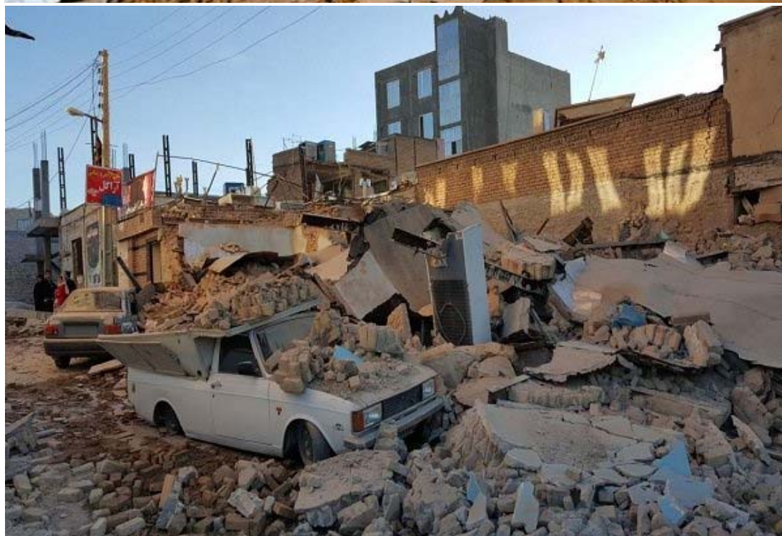
شکل ۴-۱۲: فروریزش دیوار پیرامونی در کرمانشاه
