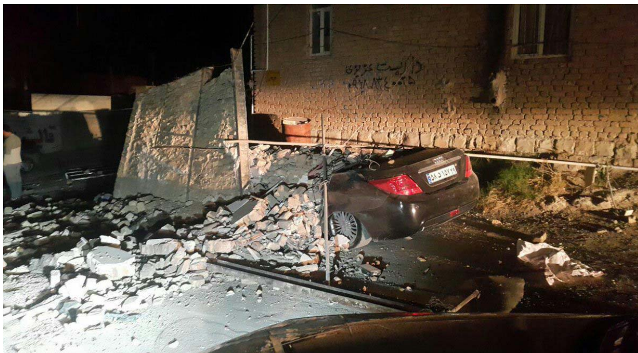
شکل ۴-۸ تخریب دیوار منزل مسکونی و آسیب به خودرو در سرپل ذهاب
