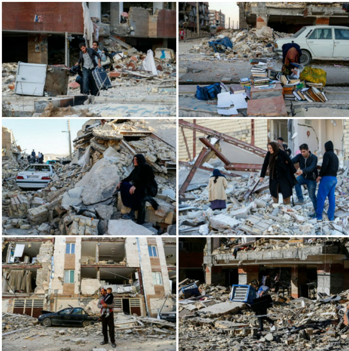
۴-۲۴: تخریب گسترده ساختمانهای شهری در کرمانشاه
